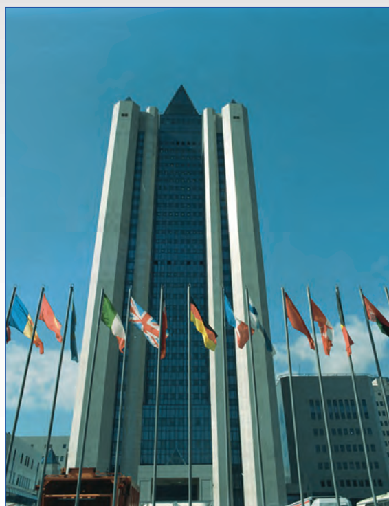
Центральный офис ОАО «Газпром»
